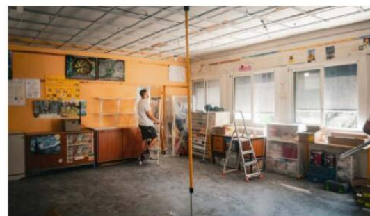
Dans les écoles seynois, les entreprises se succèdent tout l'été afin que les chantiers soient achevés avant la rentrée.
