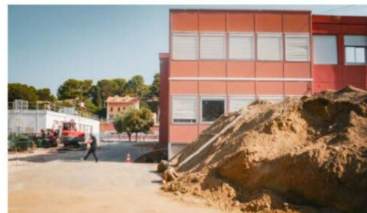
À Rousseau, le gros du chantier de désimperméabilisation débutera aujourd'hui, une fois les centres de loisirs fermés et les écoles totalement libérées.
